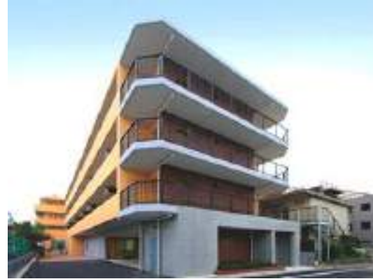
ファミニュー大森南新築工事
