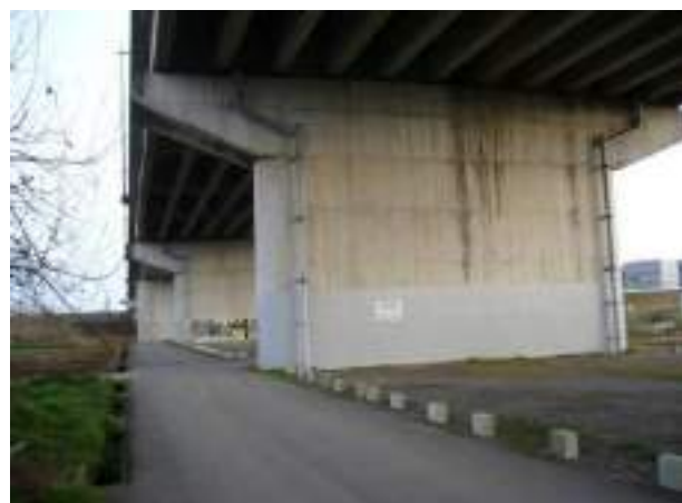
美合橋 橋脚 落書き防止塗装
