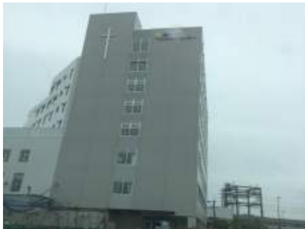
聖マリアヘルスセンター 新築工事
