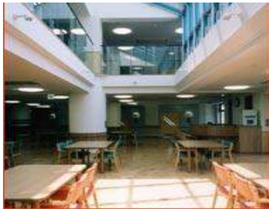
第二清風園改修工事
