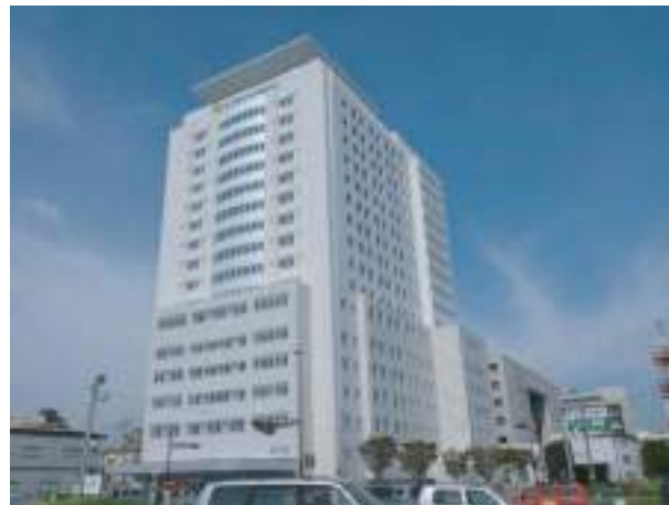
聖マリア病院 国際医療センター 新築工事
