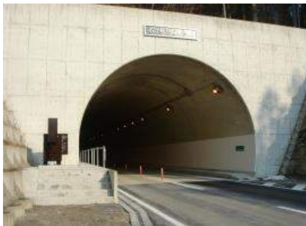
国道421号線 石榑トンネル 視線誘導塗装
