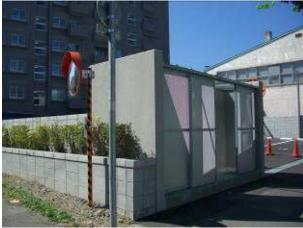
ゴミ置き場 防臭メンテナンス軽減施工
