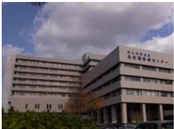
国立名古屋医療センター トイレ臭気対策
