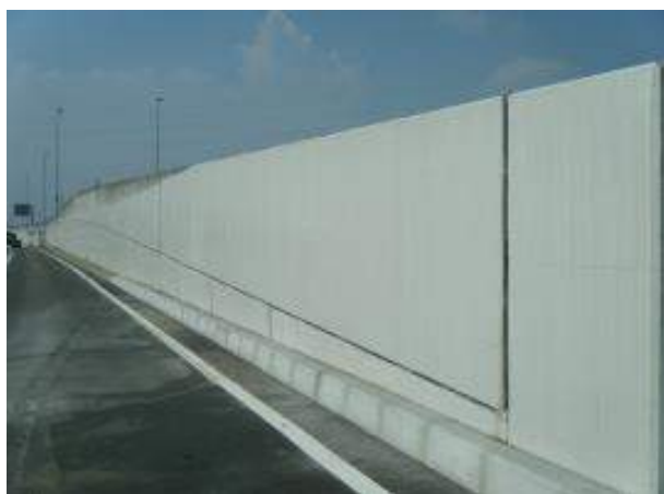
国道23号線 擁壁 落書き防止塗装
