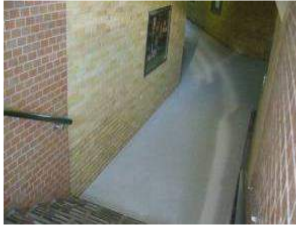
地下道 防臭・清掃メンテナンス軽減施工
