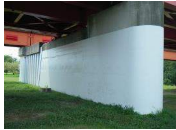
嶋大橋有料道路 橋脚 落書き防止塗装
